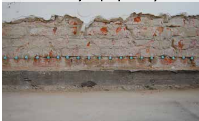
Cihlové zdivo týden po aplikaci injektáže
