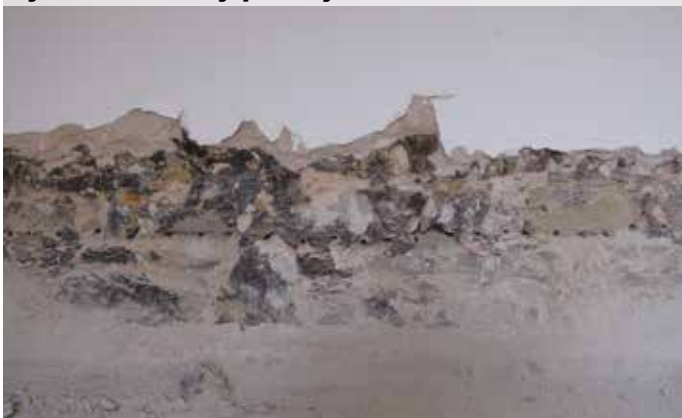
Vyvrtané otvory pro injektáž v kamenném zdivu
