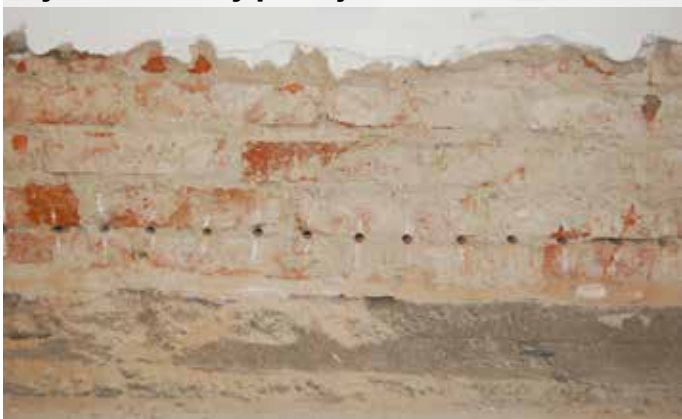
Vyvrtané otvory pro injektáž v cihlovém zdivu
