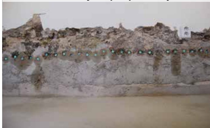
Kamenné zdivo týden po aplikaci injektáže
